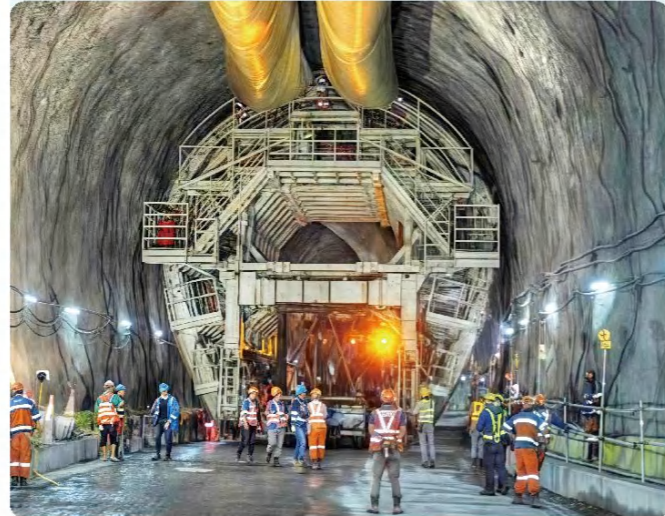
广深港高铁香港段 820 项目 820 PROJECT OF HONG KONG SECTION OF GUANGZHOU-SHENZHEN-HONG KONG HSR
