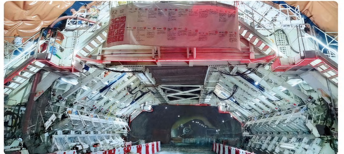
香港中九龙干线隧道项目 TUNNEL PROJECT OF HK-CNR
