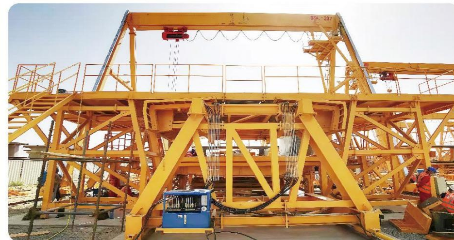
阿联酋迪拜立交桥项目 UAE DUBAI OVERPASS PROJECT
