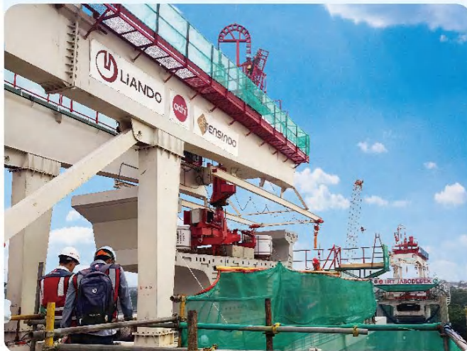
雅加达 LRT 项目 LRT PROJECT IN JAKARTA
