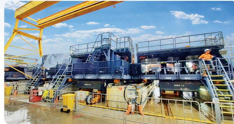
澳大利亚布里斯班 桥梁项目 BRISBANE BRIDGE PROJECT
