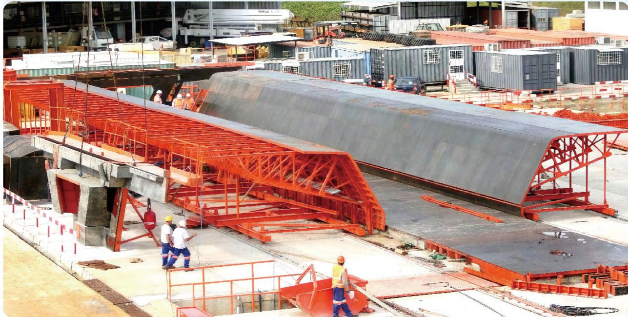
科特迪瓦阿比让大桥 50 米箱梁项目 BOX GIRDER (50M) FOR ABIDJAN BRIDGE PROJECT IN IVORY COAST
