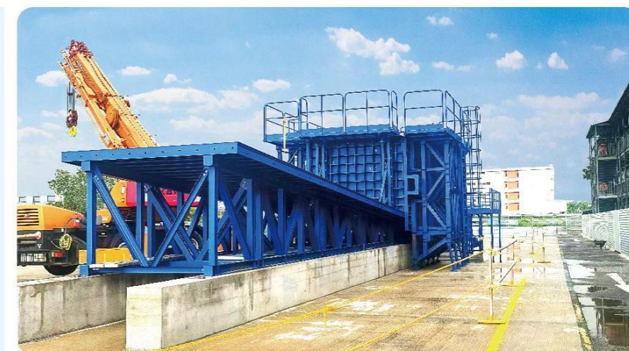
新加坡裕廊 J112 项目 J112 PROJECT FOR SINGAPORE
