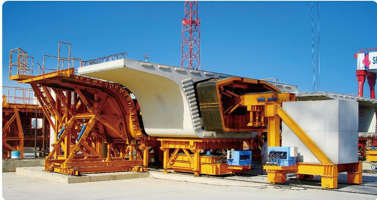
伊朗德黑兰立交桥项目 OVERPASS PROJECT IN TEHRAN, IRAN
