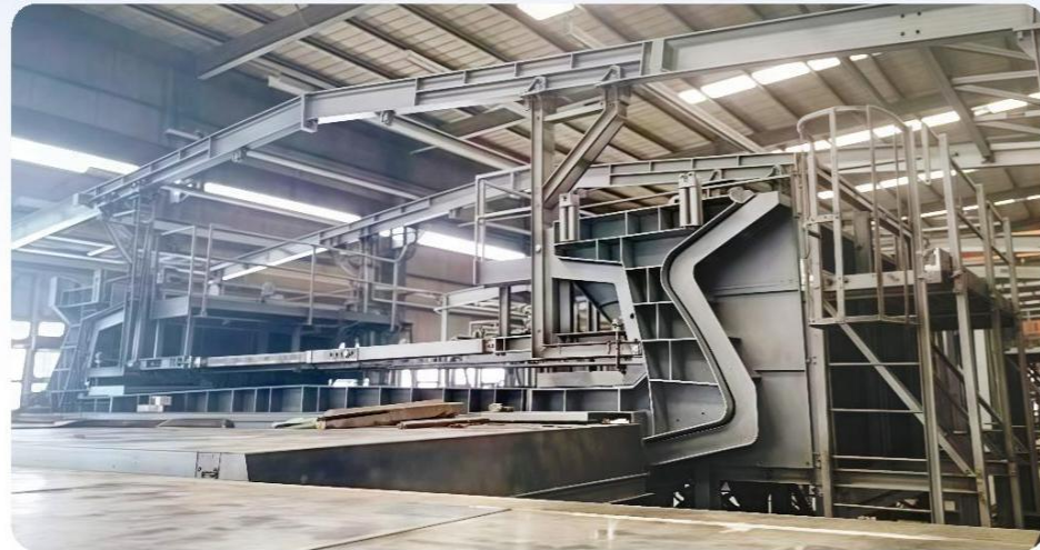
越南地铁项目 VIETNAM SUBWAY PROJECT
