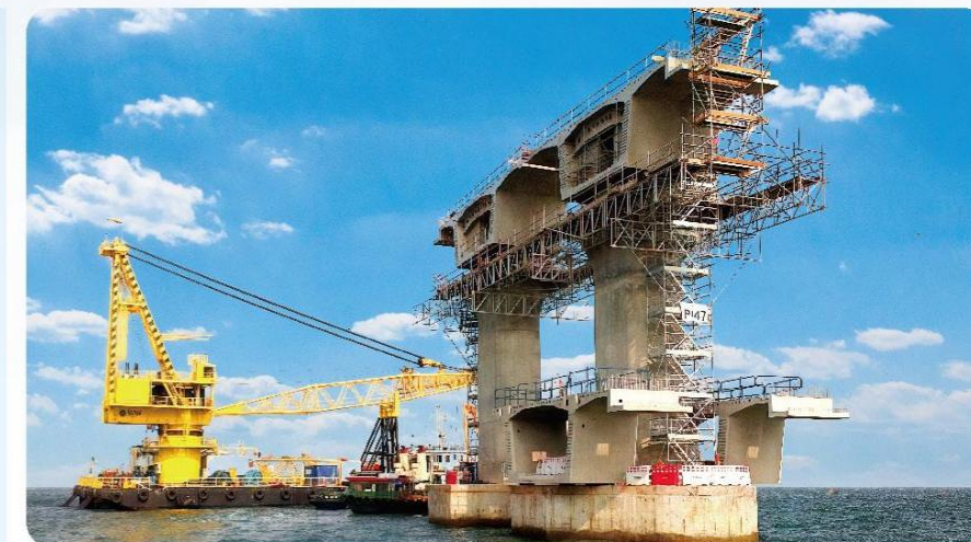
港珠澳大桥项目 HONG KONG-ZHUHAI-MACAO BRIDGE PROJECT (HK SECTION)
